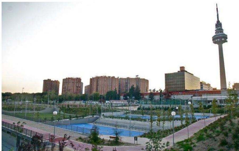
Figura 15: Vista general de la Instalación deportiva Torrespaña
