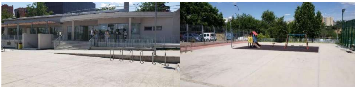
Figura 18: Edificio de vestuarios y usos varios, y zona de columpios con ausencia de bancos y zonas verdes
