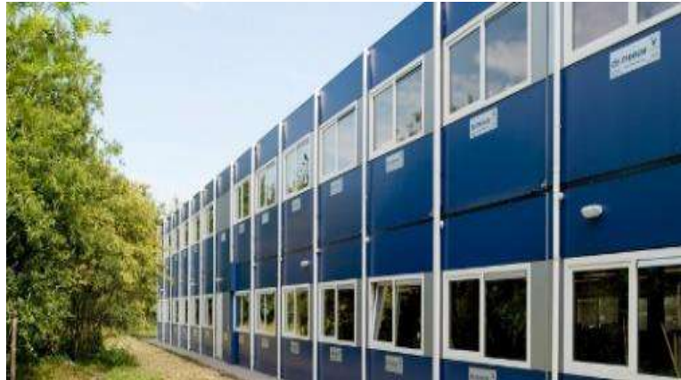
Ejemplo de estructura modular (Países Bajos)
