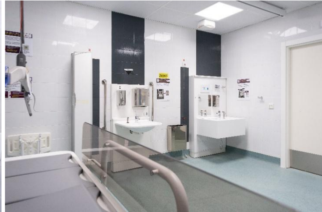
Imagen 5: Interior de un Cambiador GAMAN
