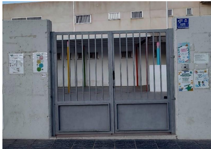
Imagen 22: Puerta principal de acceso de colegio
