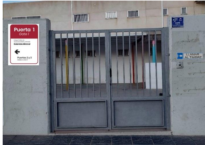
Imagen 23: Ejemplo señalización puerta principal y timbre
